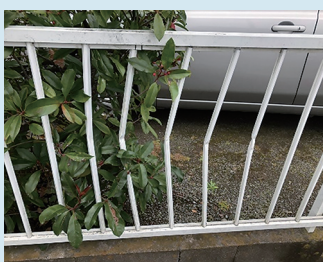
フェンスの変形
